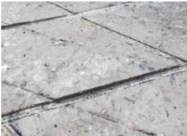
**Figura 4.** Rayado de pisos realizado con discos.
