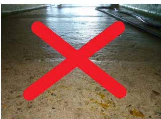
**Figura 6.** Piso no apto, liso, propenso a generar resbalones y caídas.
