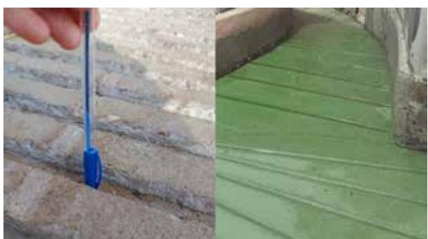
**Figura 1.** Piso en corrales y pasillos de hormigón ranurado.
