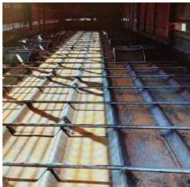
**Figura 6.** Pisos inadecuados según la Resolución SENASA 503/2022. Este piso si bien aparenta ser una malla cuadriculada, no es acorde ya que las nervaduras longitudinales son cañuelas que pueden hacer más difícil el agarre, además de que la altura de la nervadura transversal es muy elevada y puede hacer que un animal chico se enganche y tropiece.
